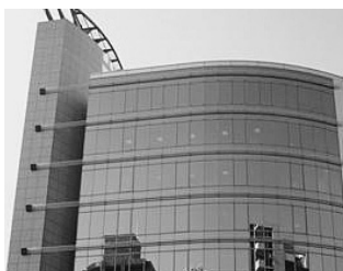
西日本地連の入居する富士商ビル
